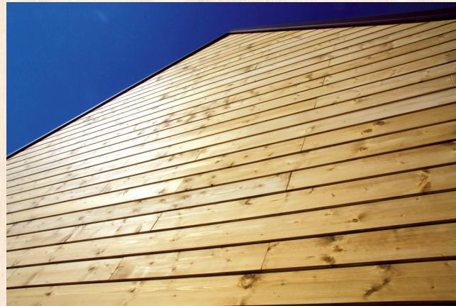
Na tuzemské dreviny ako SMREK, JEDĽA a BOROVICA je nutné pred aplikáciou oleja vždy najskôr povrch impregnovať (**Imprägniergrund W213**). Impregnácia sa aplikuje natieraním alebo máčaním a jej úlohou je ochrániť drevnený podklad pred drevokaznými hubami a hmyzom. Použitie tejto impregnácie podstatne predlžuje životnosť povrchovej úpravy, nakoľko hlboko vsakuje do podkladu a dôkladne impregnuje podklad.
