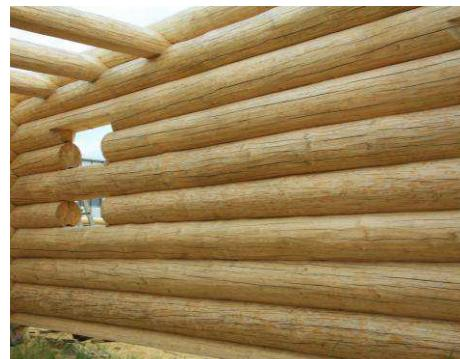
Pokiaľ je požiadavka na konečnú povrchovú úpravu v svetlom odtieni a požiadavkou na povrchovú štruktúru je hobľovaný vzhlad, je nutné drevo ešte pred výstavbou ochrániť pred prirodzenou oxidáciou (žltnutím), ktorá vzniká pôsobením slnečného UV žiarenia. Takúto ochranu poskytuje olejový náter *DIOTROL IMPRENOL*.
